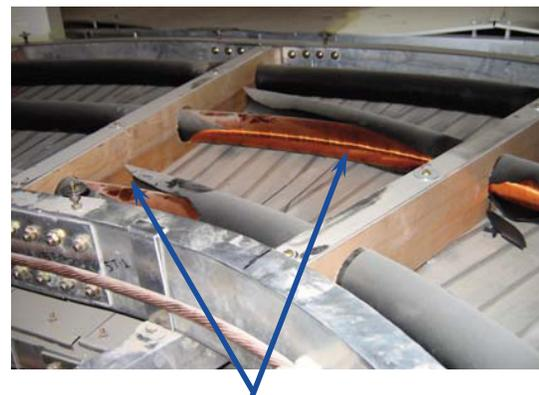
*Défaillance d'une gaine LSZH causé par le résidu d'un système de conduit adjacent*
