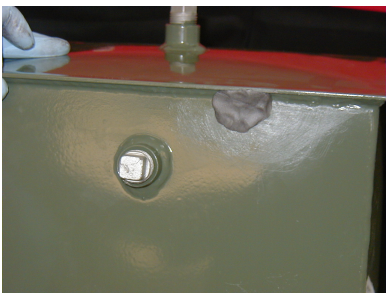
Aplique masilla para cubrir a 15 mm de todos puntos de la filtración
