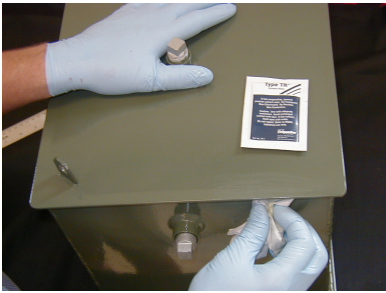
Limpie la area con Limpiador Tipo TR™ antes de aplicar la masilla PowerPatch™
