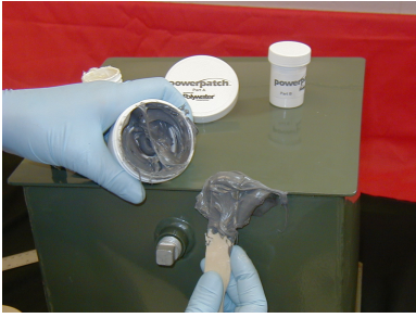
Aplique el sellador PowerPatch sobre la masilla y/o la área de filtración
