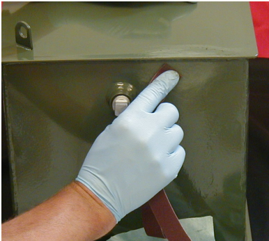
Limpie la área de la filtración con cepillo de metal o papel de lija
